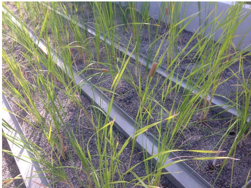
Le marais épurateur à flux vertical
