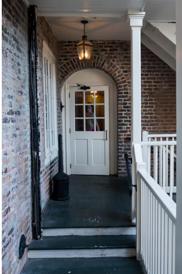
Figure 3 Corridor entre les deux bâtiments de l'hôtel
