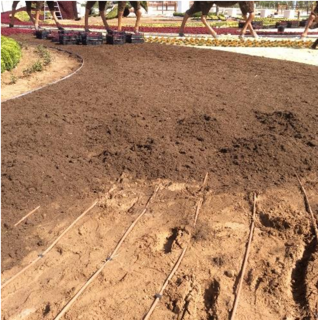
Figure 17 – Détails. Pose des tuyaux d'irrigation goutte à goutte dans les plates bandes par section.
