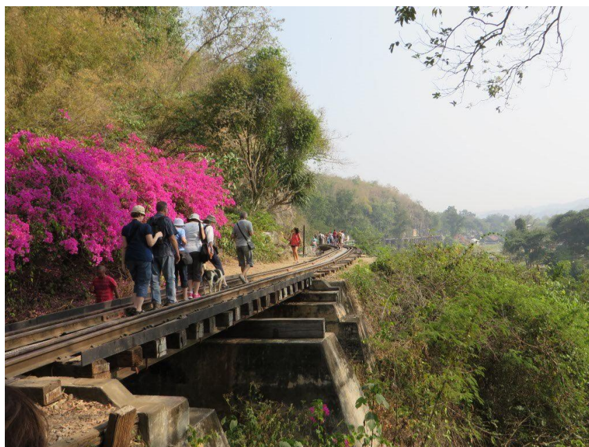
Traverse sur la voie ferrée
